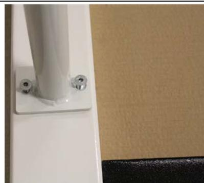
Handlauf an der entsprechenden Stelle auf die Waage aufsetzen und mit den 4 Schrauben fixieren.
